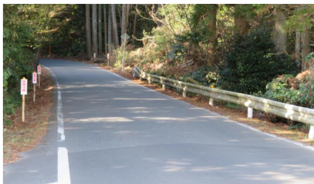
勝浦荒川線の危険個所
